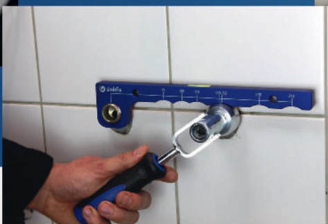
Ausrichten der S- Anschlüsse.
