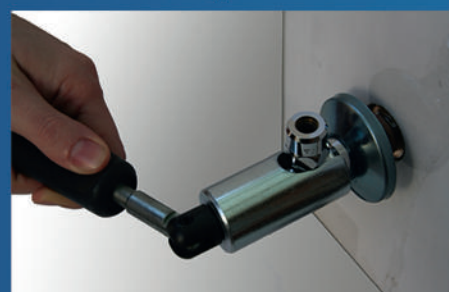
Ein- und Ausschrauben von Eckventilen
